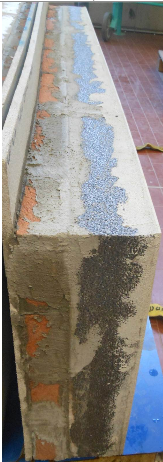
Figura 8. Riproduzione fotografica, al termine degli 80 cicli Heat-Rain + 5 cicli Heat-Cold e prima dell'esame visivo di aspetto, di un particolare del pannello "TermoK8 Modular Big".
